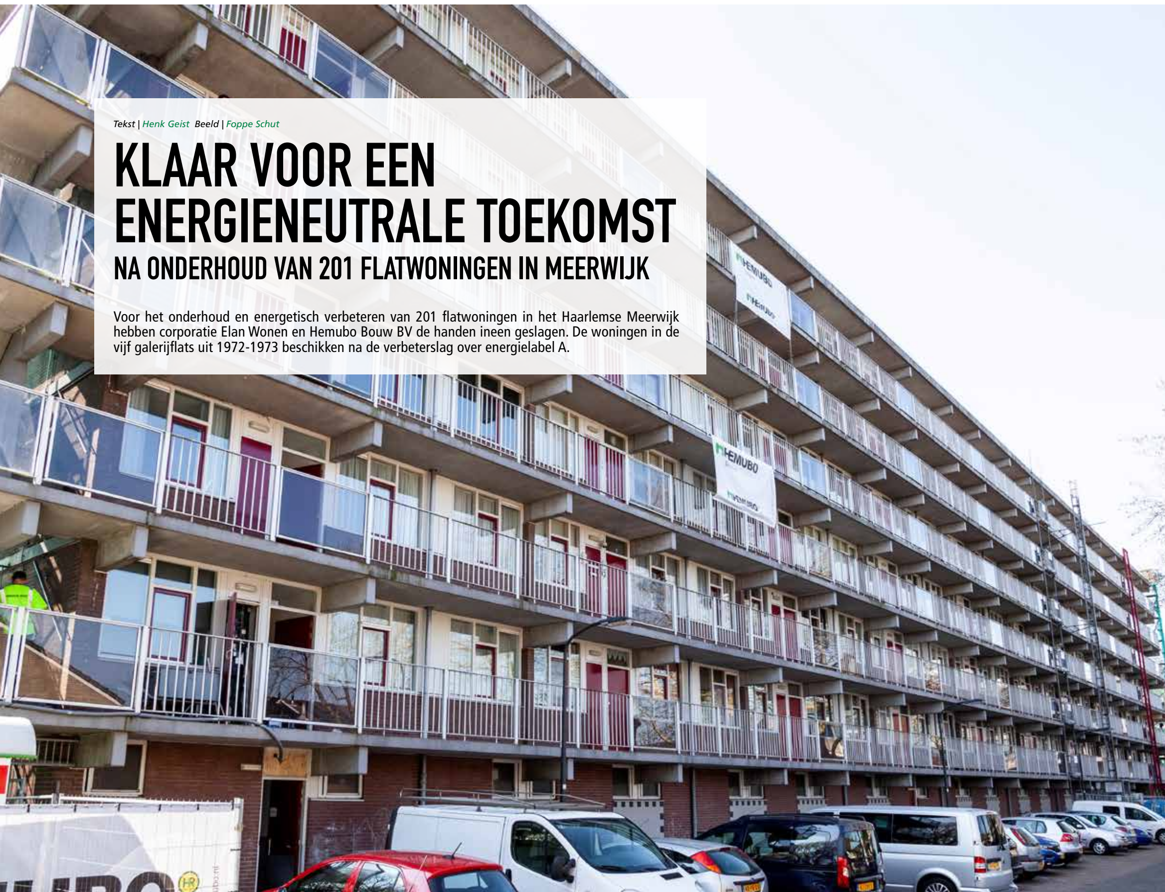
Situatie voor de renovatie, met oude balkonhekken.
