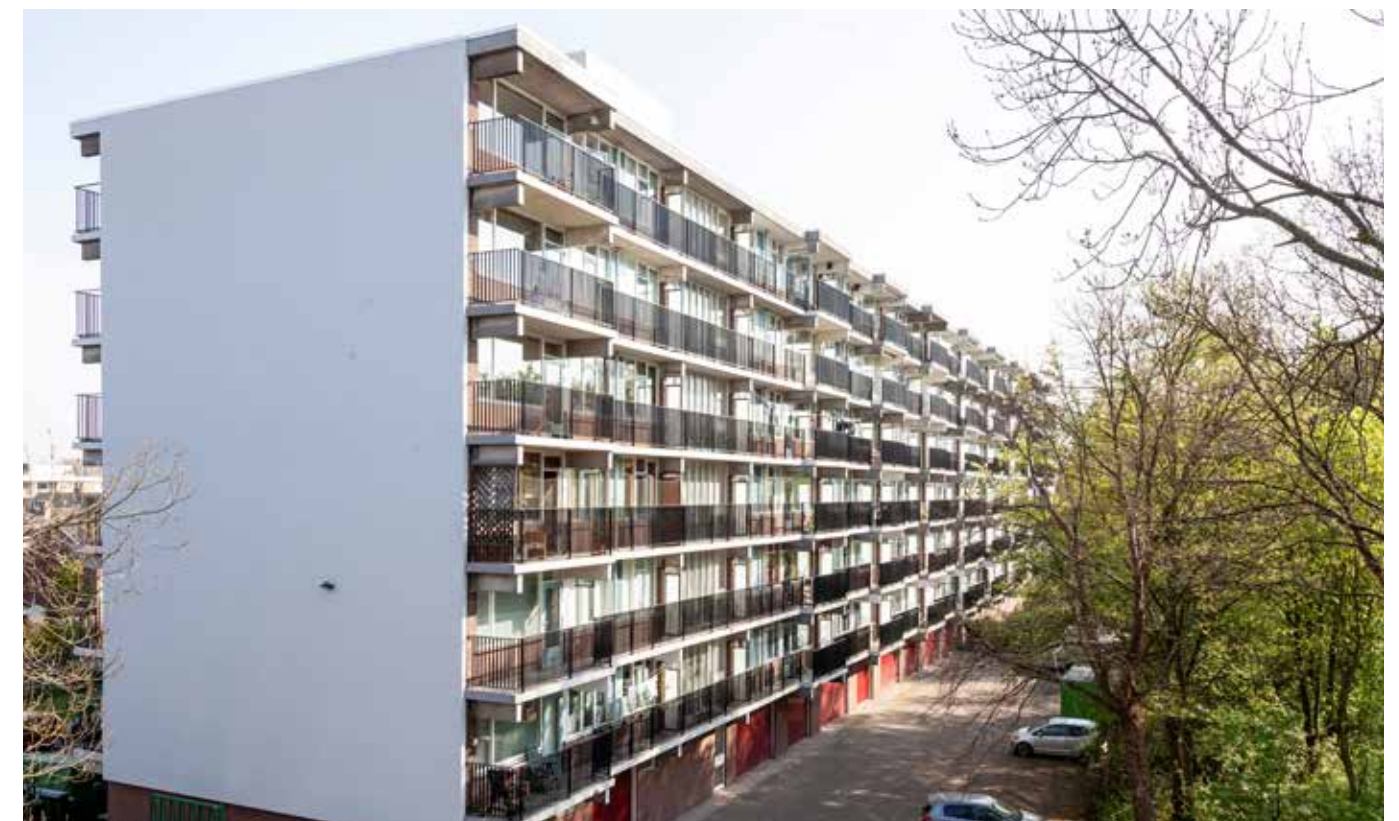
Situatie na de renovatie met nieuwe balkonhekken en een geïsoleerde kopgevel.
